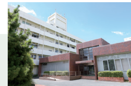
先導物質化学研究所外観
