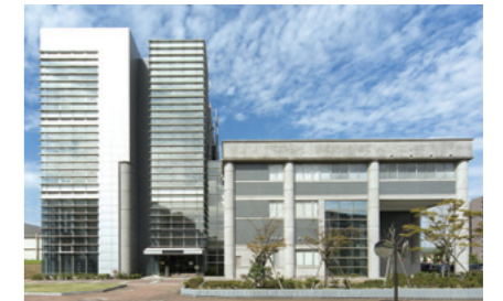
オープンイノベーション棟外観 (1階にクリーンルームがあります)
